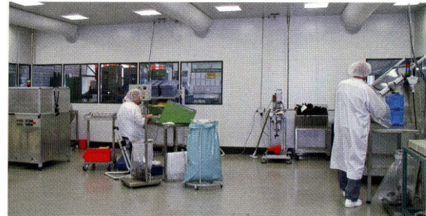
Wegen der fehlenden Standardisierung in der industriellen Reinigungstechnik verfügen Unternehmen häufig nicht über die notwendigen Informationen, um zwischen Rein- oder Sauberraumerfordernissen zu unterscheiden. Bilder: Nerling Systemräume
